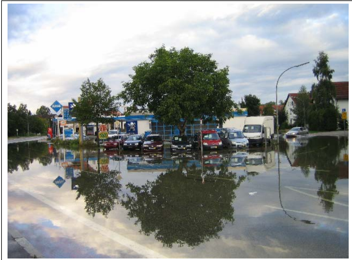
Abb. 19: Aufgestautes Grundwasser erreicht eine Tankstelle (Freising, Ortsteil Lerchenfeld)
