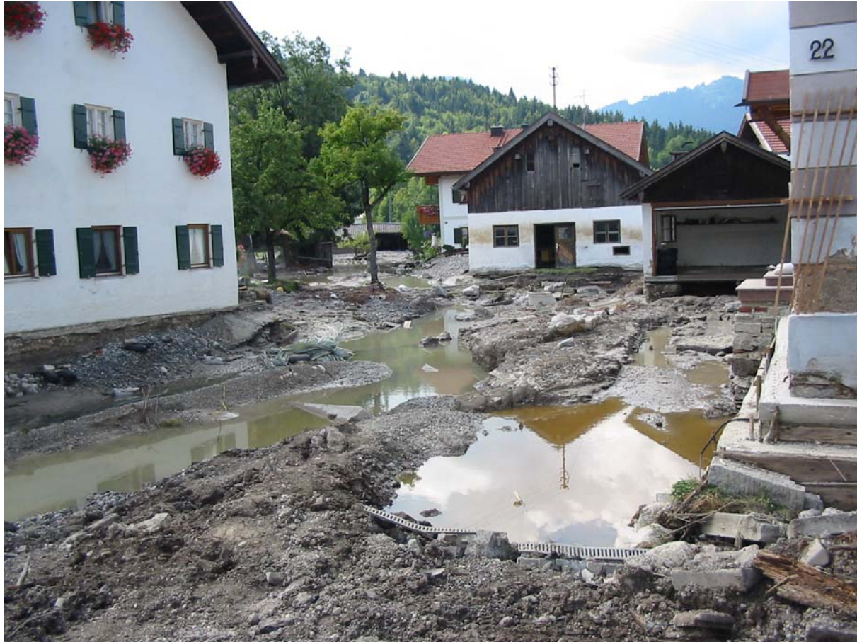
Abb. 1: Hochwasserschäden in Eschenlohe
